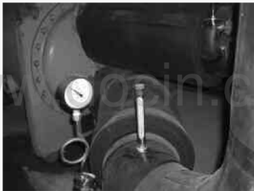
图9.10 压力表和温度计的安装示意图
