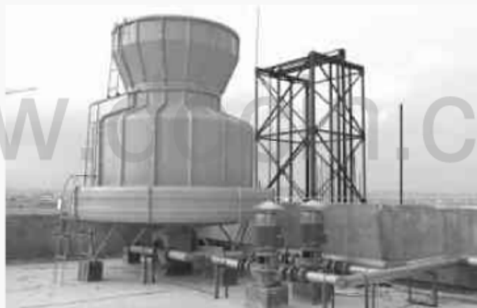
图9.6 冷却塔高位安装示意图
