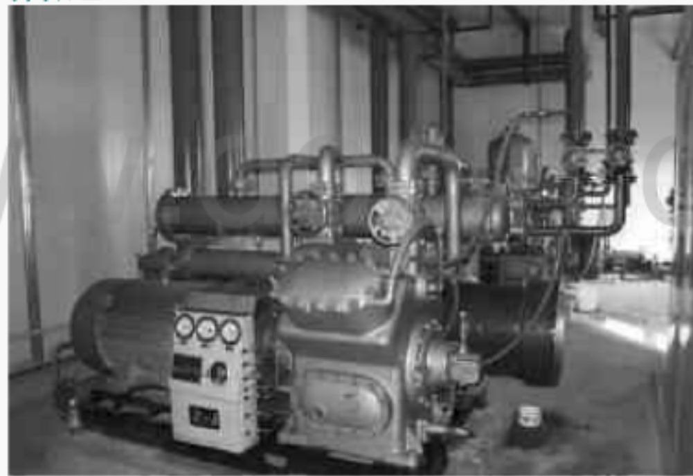
图9.4 活塞式制冷机组示意图
